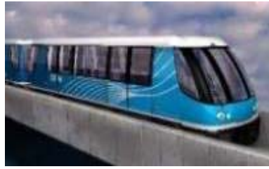
Innovia * - Flughafen Dallas/Fort Worth (USA)
